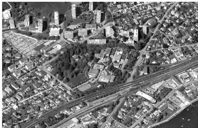
Vue aérienne du site de Beausobre, Ville de Morges
